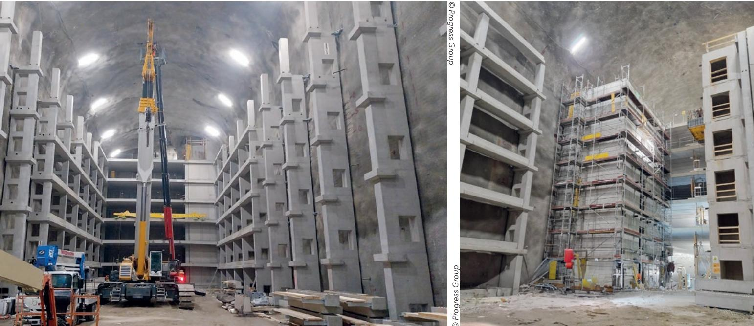
Unter den Straßen von Meran wird momentan ein äußerst beeindruckendes Infrastrukturprojekt umgesetzt: eine sechsstöckige Tiefgarage im Küchelbergtunnel. Die 170 m lange Hauptkaverne, die über einen Tunnel vollständig erreichbar ist und einen direkten Fußgängerzugang zur Innenstadt bietet, ist eine technische Meisterleistung.
