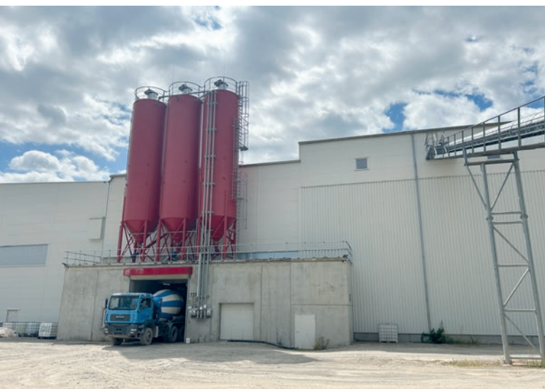
Ein vorgelagerter Gebäudeteil dient als Meisterbüro, Lagerraum für Zusatzmittel und Aufstellebene für Bindemittelsilos.
