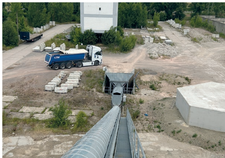
Das 6-Kammer-Reihensilo wird über einen Flachaufgabebunker (Lkw-Komplettladung) und ein Bandsystem beschickt.
