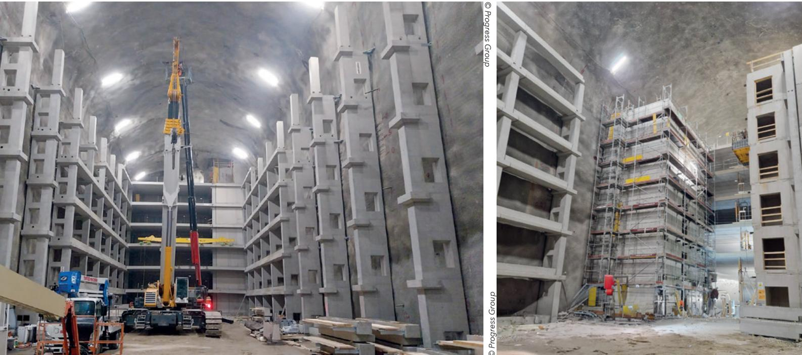
Merano 街道下方正在实施一项令人惊叹的基础设施工程: Küchelberg 隧道内的六层地下停车场。这座 170 米长的主洞穴可通过隧道全天候进出, 并设有直通市中心的步行通道, 堪称工程技术杰作。
