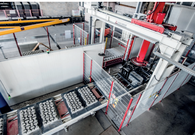
干区全自动码垛机 Servo Pak 700-2 正在精准堆垛铺路砖
