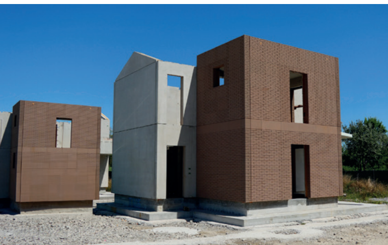
处于毛坯状态的度假屋，配有 3D 混凝土打印立面构件
