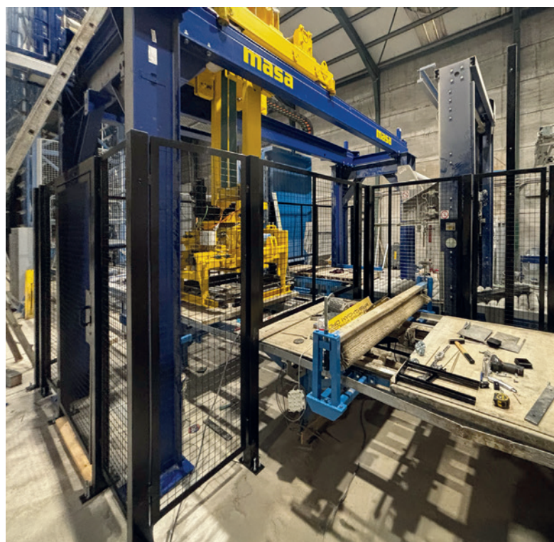
Монтаж новой установки Masa Cuboter
