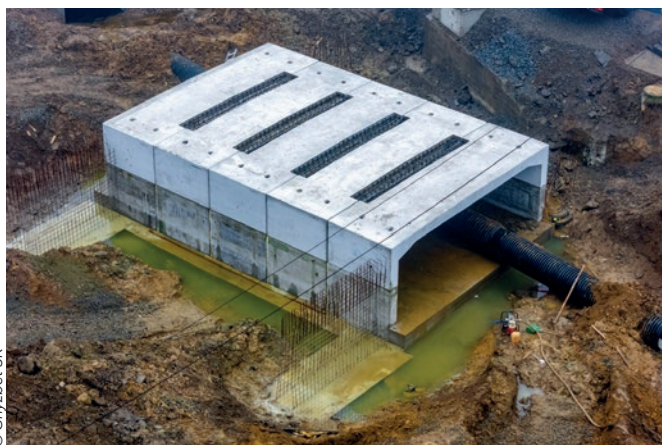
Prefabrykaty mostowe Chyżbet po zakończonym montażu.
