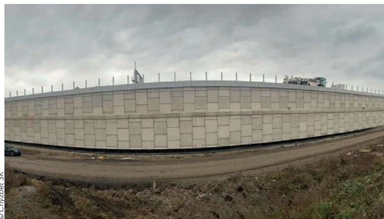
Płyty z betonu w jakości betonu architektonicznego.
