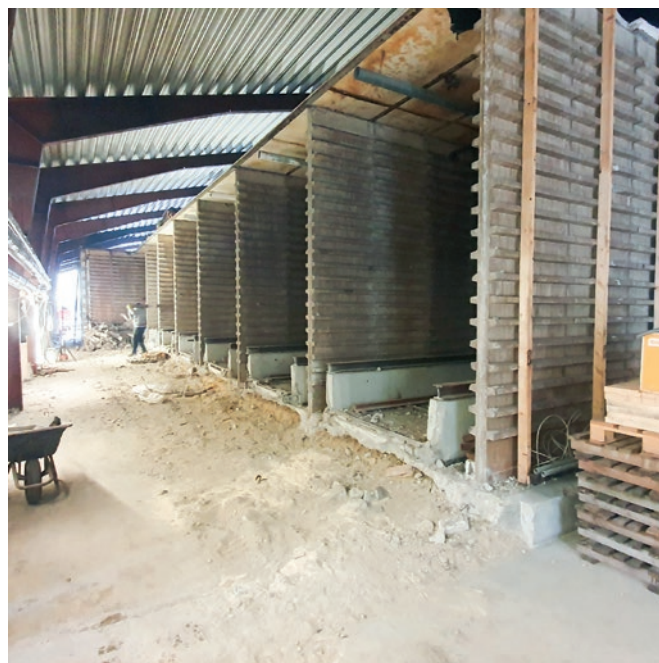
Komory przed przebudową w 2023 roku.
