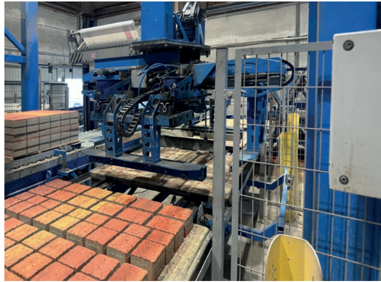
Al banco di prova: impianto di cubaggio precedente
