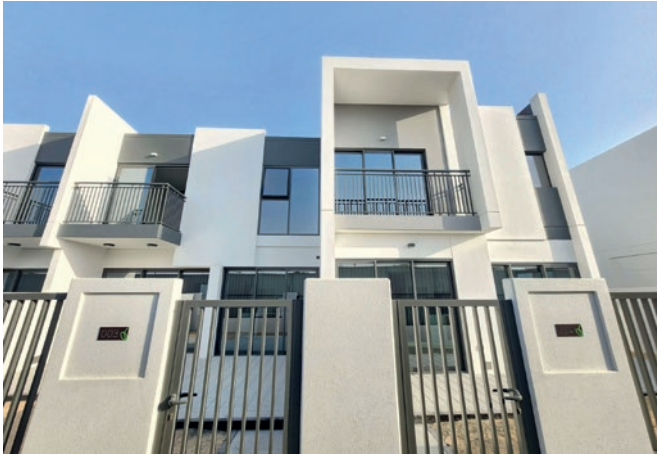
Villa Nova La Rosa, ein Projekt, das mit Betonfertigteilwandelementen ausgeführt wurde.
