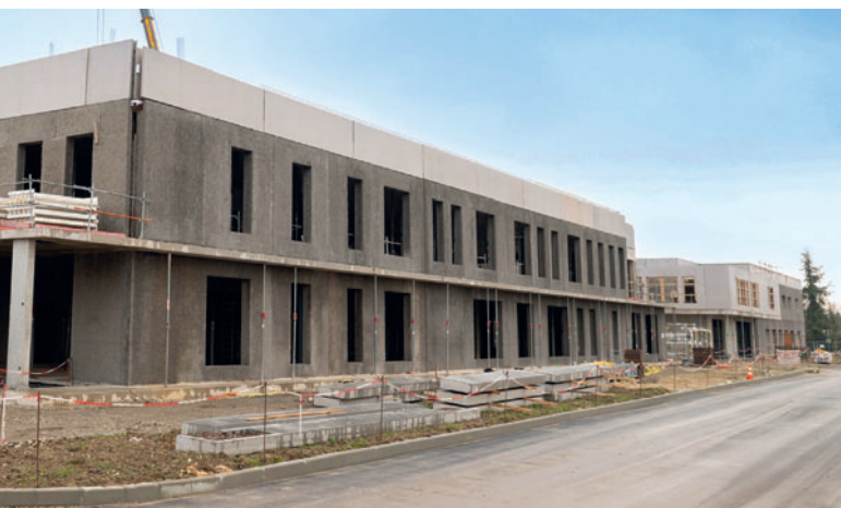
Установка древеснобетонных стеновых панелей, двойных стеновых панелей с низким содержанием CO 2 , а также стеновых панелей Isopré в больнице Bouguignes в Туре
