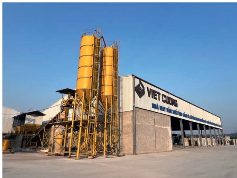
Hala produkcyjna Viet Cuong Concrete widoczna z zewnątrz.
