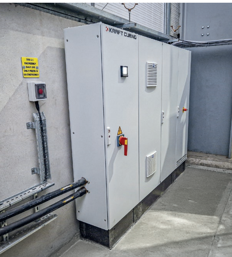
Z lewej: Jednostka ogrzewania i cyrkulacji powietrza KC 500 Convect-Air®, podłączona do oryginalnego kanału. Z prawej: Szafa sterownicza do wielostopniowego sterowania elektryczną wężownicą grzewczą o mocy 500 kW, która gwarantuje minimalną temperaturę 40°C przez cały rok.
