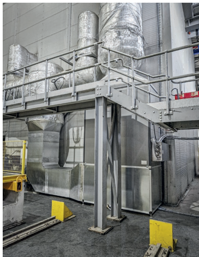
Z lewej: Jednostka ogrzewania i cyrkulacji powietrza KC 500 Convect-Air®, podłączona do oryginalnego kanału. Z prawej: Szafa sterownicza do wielostopniowego sterowania elektryczną wężownicą grzewczą o mocy 500 kW, która gwarantuje minimalną temperaturę 40°C przez cały rok.
