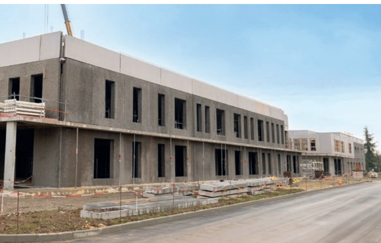
Montaż ścian z trocinobetonu, ścian podwójnych o niskiej emisji CO 2 oraz ścian Isopré na terenie szpitala Bouygues w Tours.
