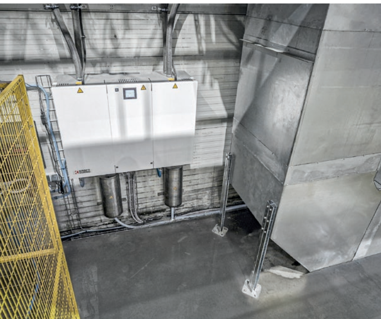
Le système AutoFog, d'une capacité de 100 kg/h, injecte de la vapeur directement dans le conduit de circulation d'air, augmentant ainsi l'humidité relative de l'air dans la chambre de durcissement si nécessaire.
