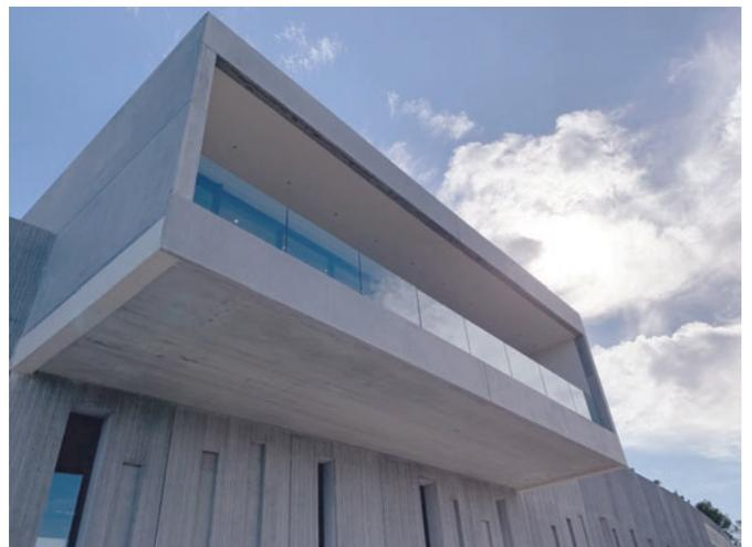
La cave à vin Méfifiot à Saint-Rémy-de-Provence a été réalisée avec des prémurs Spurgin en construction matricielle.
