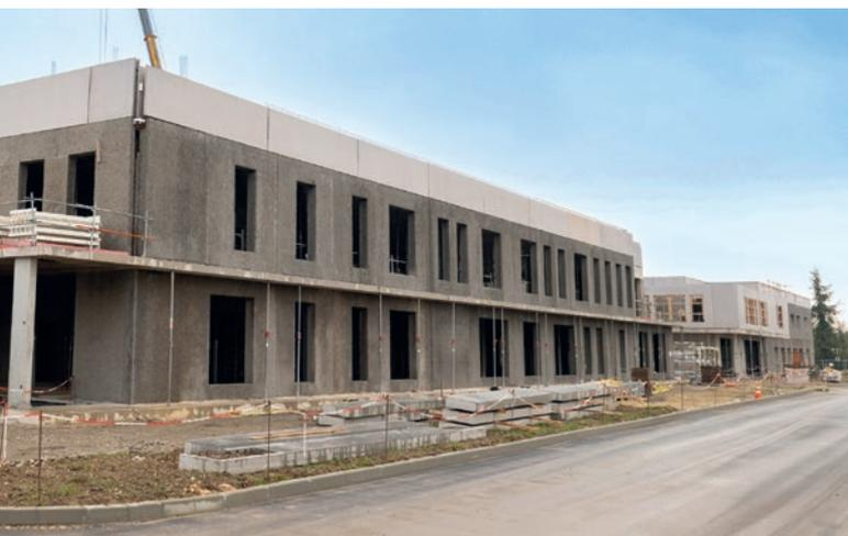
Chantier Bouygues de l'hôpital de Tours, réalisé avec des murs en béton de bois, des prémurs en béton bas carbone et des éléments Isopré.
