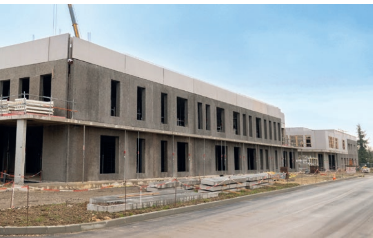
Instalación de muros de hormigón de madera, muros dobles con bajo contenido de CO 2 y muros Isopré en el hospital Bouygues de Tours.
