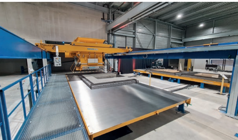
Der neu konzipierte Betonverteiler dient zur Austragung des Holzbetons.
