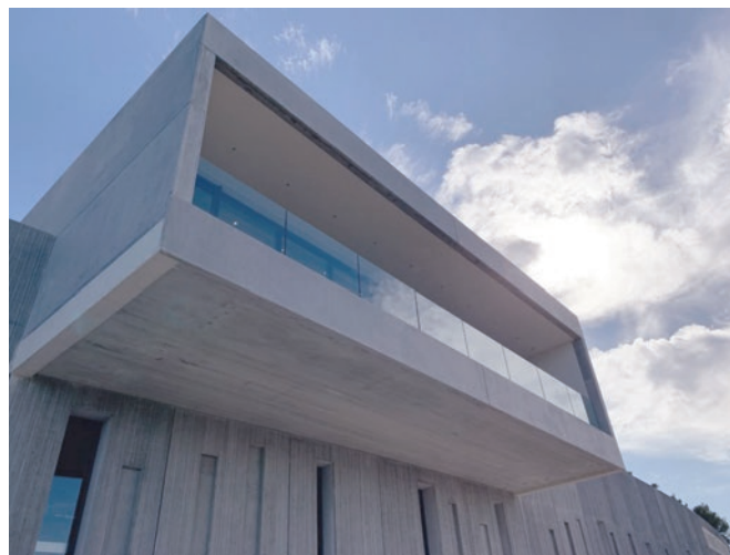
Der Métifiot-Weinkeller in Saint-Rémy-de-Provence wurde mit Spurgin-Doppelwänden in Matrizenbauweise realisiert.
