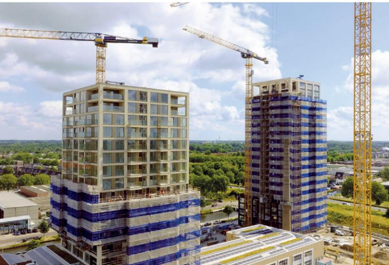
埃因霍温 De Caai 项目中所采用的 Lammers Beton 高品质预制混凝土构件，完美融合现代设计与高效施工理念
