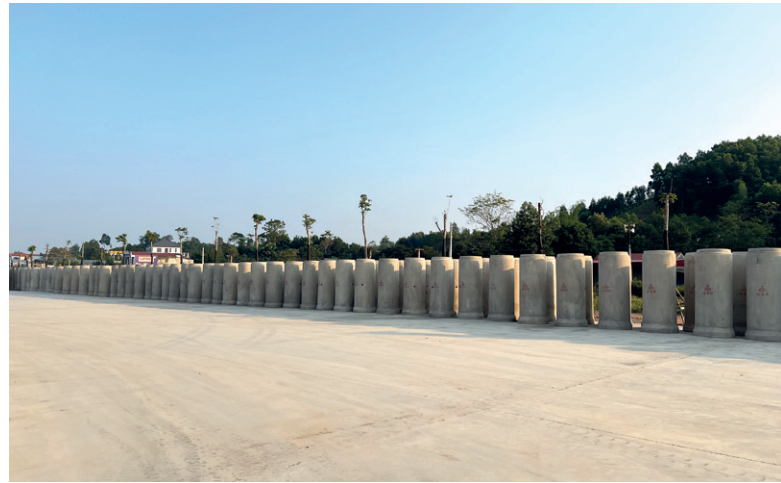
采用径向挤压工艺生产的混凝土管材养护仓储区实景
