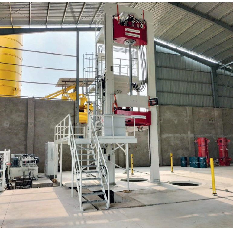
越南 VietCuong 公司全新 RP 1225-4 径向压力机安装竣工实景
