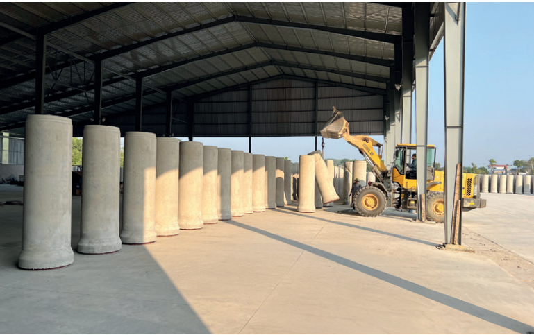
养护完成的混凝土管材转运至仓储区实景
