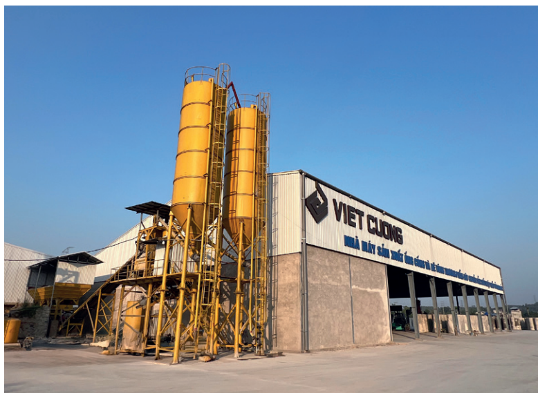
越南 VietCuong 混凝土公司生产车间外景
