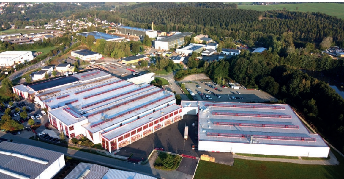
Siedziba Kobra Formen GmbH w Lengenfeld.
