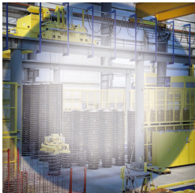
Automatizzazione della movimentazione di fondelli ed alimentazione di gabbie d'armatura
