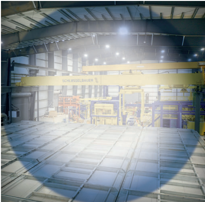
Aushärtekammern mit automatischer Beschickung
