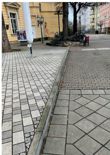
Unterschiedliche Betonsteinpflaster in der Innenstadt
