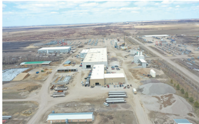
Taracon Precast 通过引进 Progress Group 的机械设备和软件对其工厂进行了现代化升级
