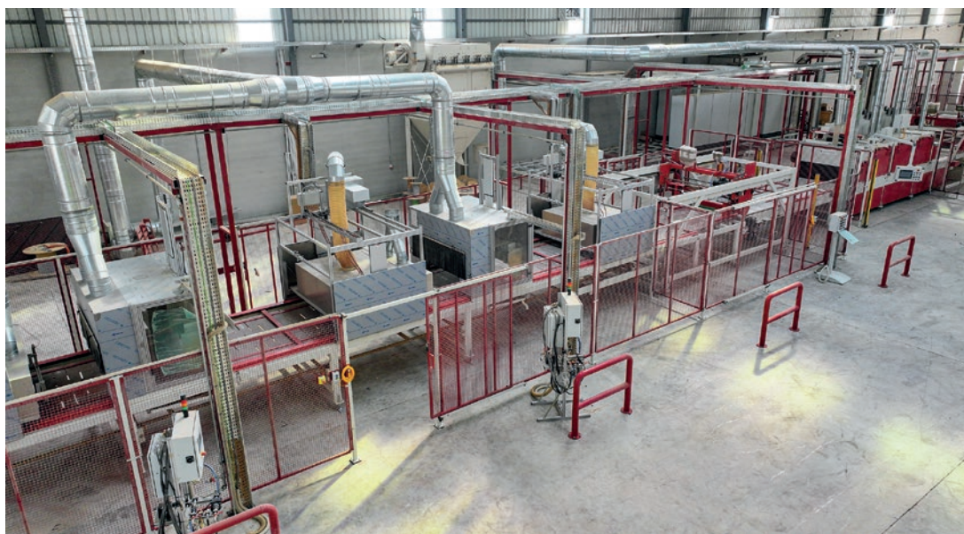
Linia powlekania (w trakcie uruchamiania).
