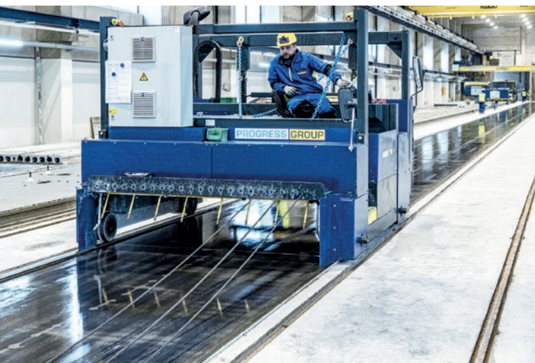
Wielofunkcyjny wózek zasilany akumulatorem służy do przygotowywania (nowego) toru: do czyszczenia i smarowania toru oraz przeciągania splotów.
