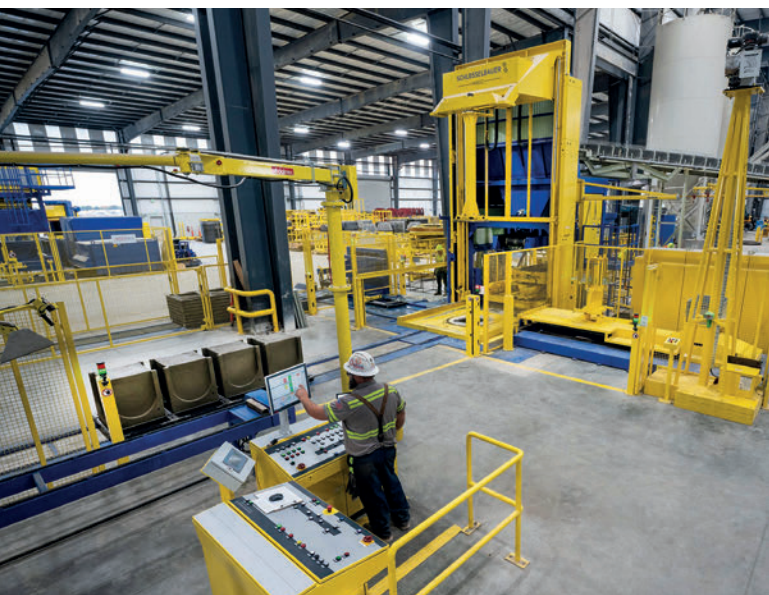
Impianto di anelli per pozzetti Magic operato da un solo utilizzatore
