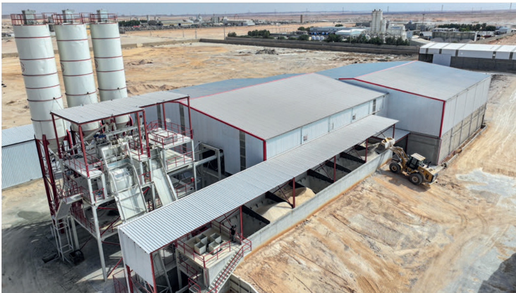
Vista esterna del sito di produzione OTC
