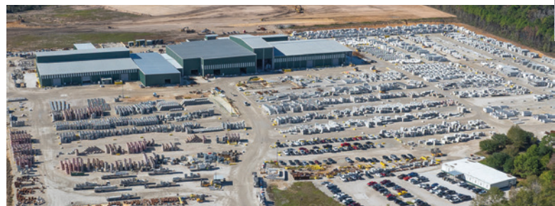
Site Ameritex de Houston - Établissement de la nouvelle unité de fabrication de regards Magic
