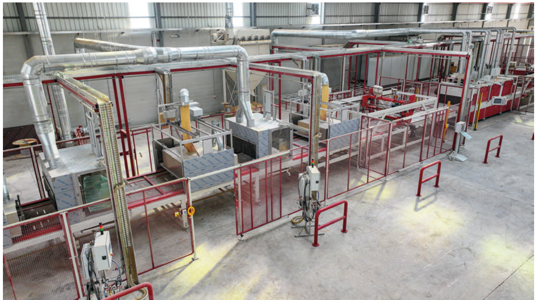
Beschichtungsanlage (bei Inbetriebnahme)
