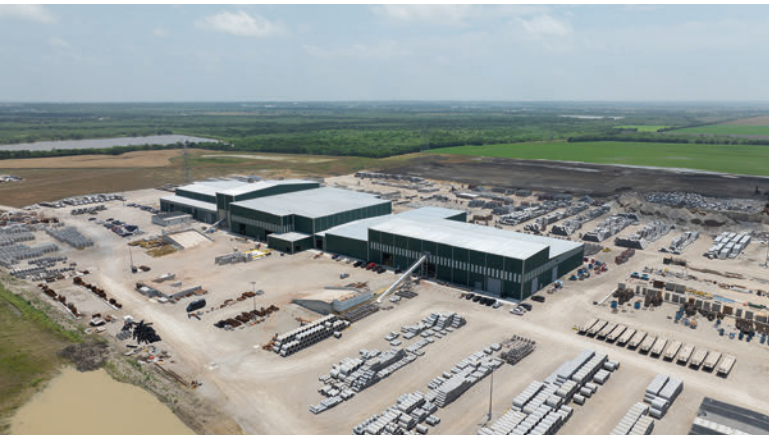
Am Standort Dallas betreibt Ameritex eine weitere vollautomatische Wet Cast Fertigung
