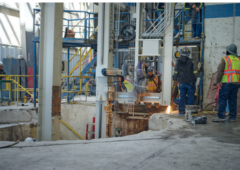
Заключительные монтажные работы
