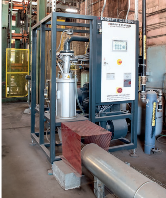
Generator pary Kraft typu 15-1S zastąpił stary kocioł grzewczy.
