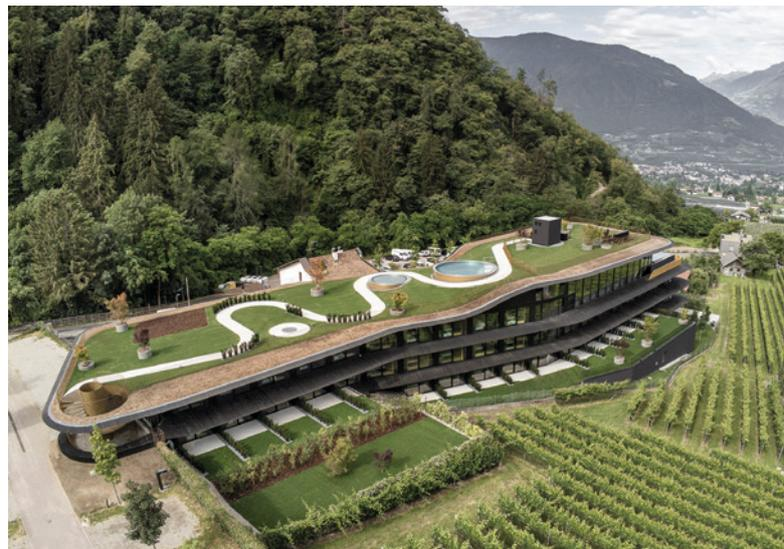
Un immobile di riferimento: l'hotel Prinz Rudolf di Merano in cui sono stati utilizzati la parete termica Green Code Thermowand® e il solaio climatizzato Green Code Green Code Klimadecke®.
