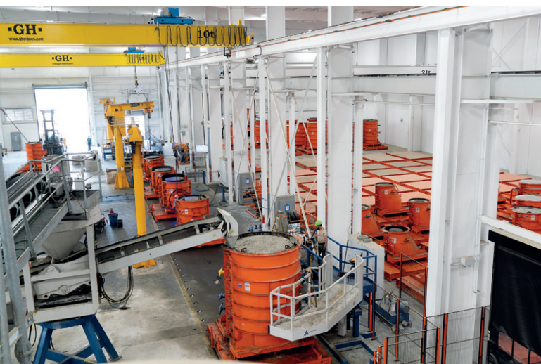
斯帕坦堡 Tindall 基础设施中 Prima 上的专用工作站
