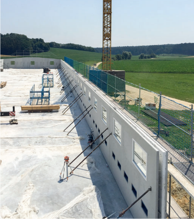
Теплоизоляционные стеновые панели также используются в сельскохозяйственном строительстве, как, например, при сооружении птичника
