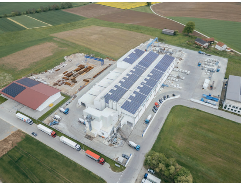
Бетонный завод Rembeck, построенный в 2012 году, теперь соответствует требованиям будущего благодаря совершенно новой циркуляционной системе от Progress Group
