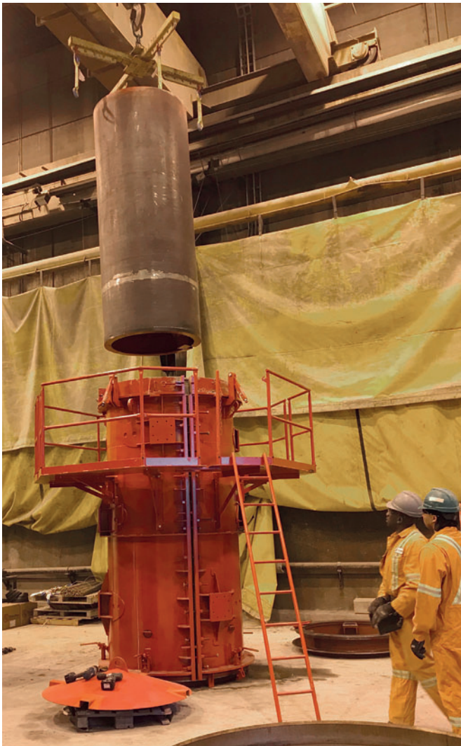
Начало распалубки – извлечение сердечника
