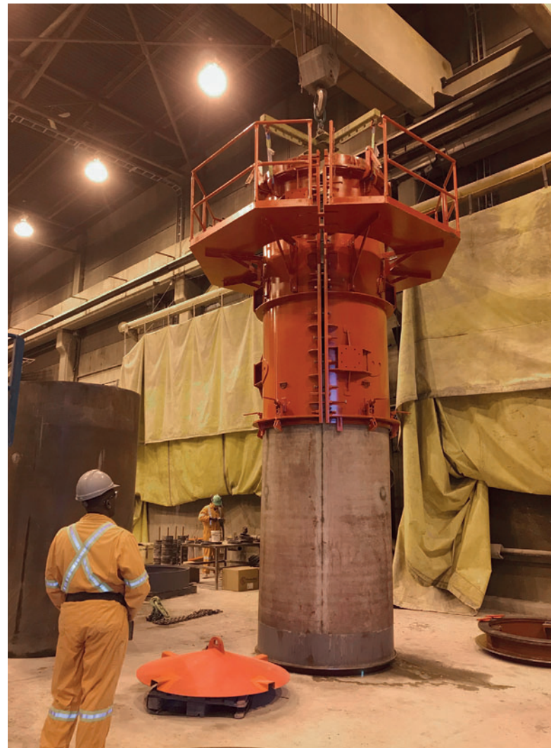
Снятие муфты – готовая обсадная труба на технологическом поддоне
