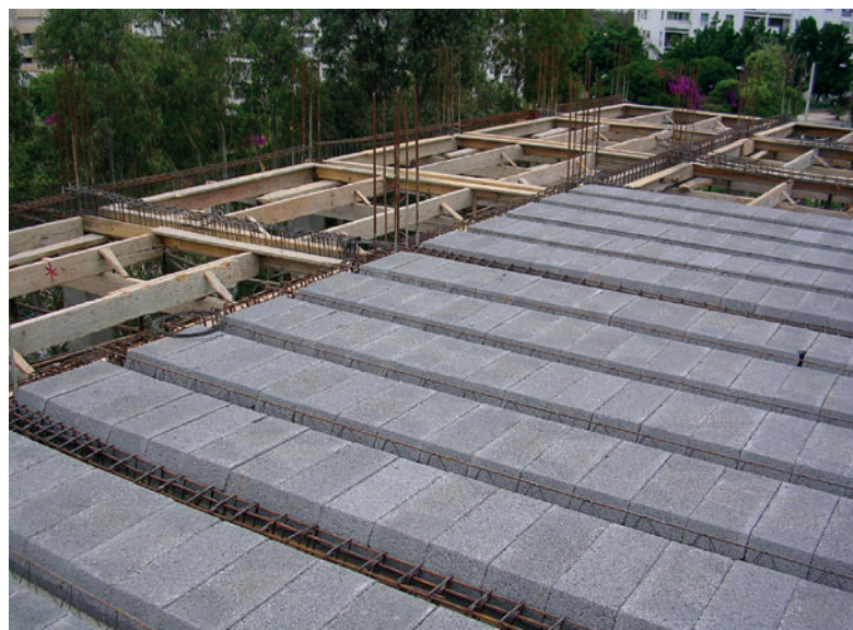
Установка блоков перекрытия
