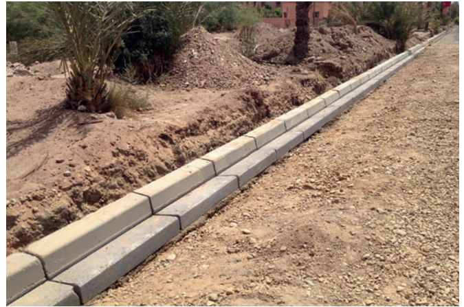
Строительная площадка в окрестностях Марракеша
