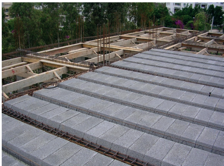
Pustaki stropowe ułożone na budowie.
