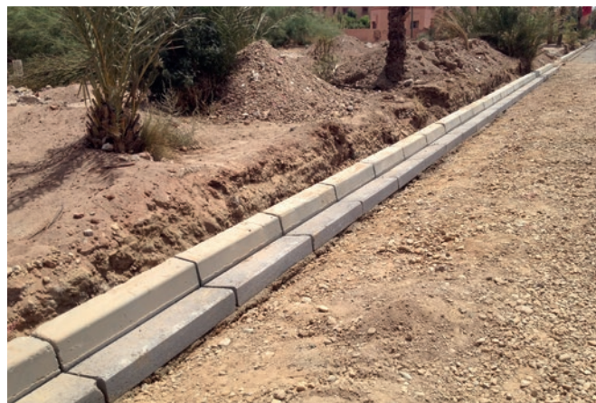
Plac budowy niedaleko Marrakeszu.
