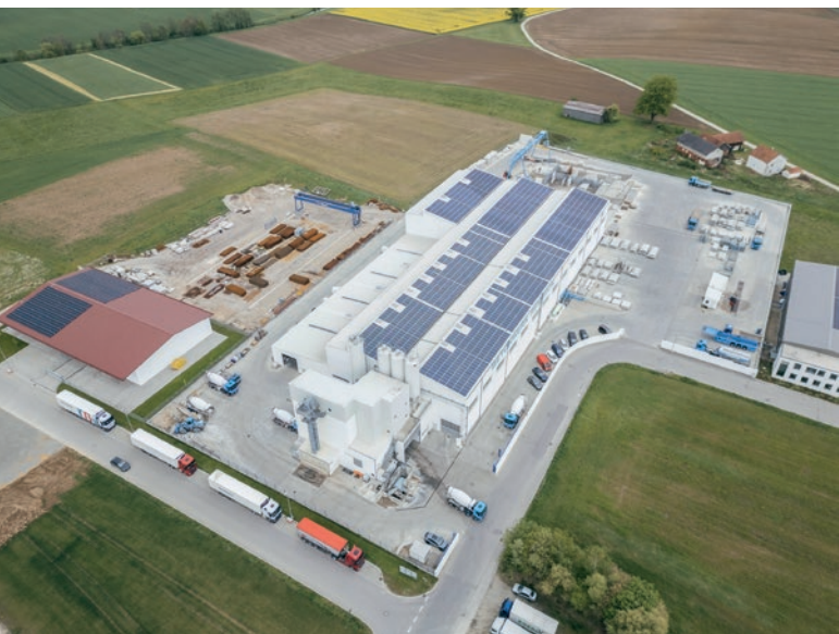
Zakład betoniarski firmy Rembeck wybudowany w 2012 roku został przygotowany na przyszłość dzięki kompletnie nowej linii obiegowej Progress Group.
