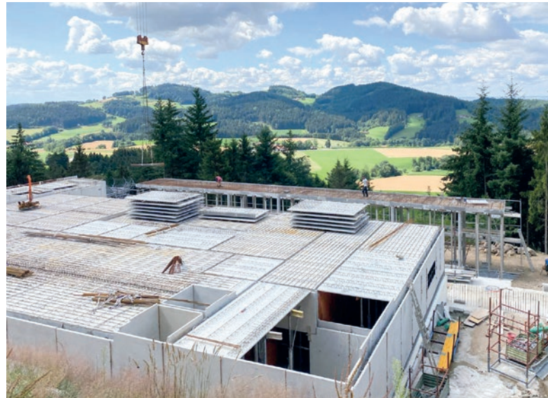
Karczma w parku rozrywki Edelwies w Lesie Bawarskim jest budowana z elementów prefabrykowanych w nowym zakładzie.
