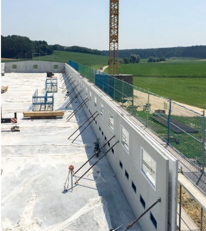
Ściany termiczne są również stosowane w budownictwie rolniczym, jak w przypadku tej fermi drobiu.
