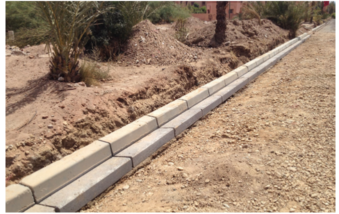
Cantiere nei pressi di Marrakech
