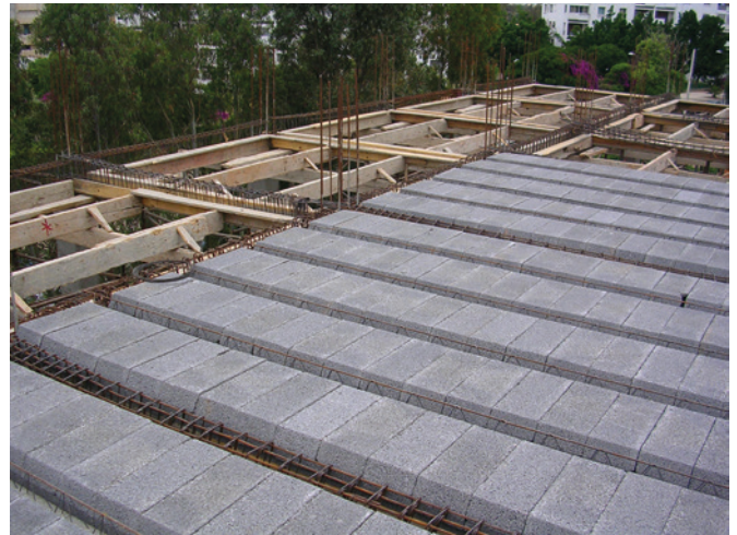
Situazione di montaggio del blocco per solai sul cantiere
