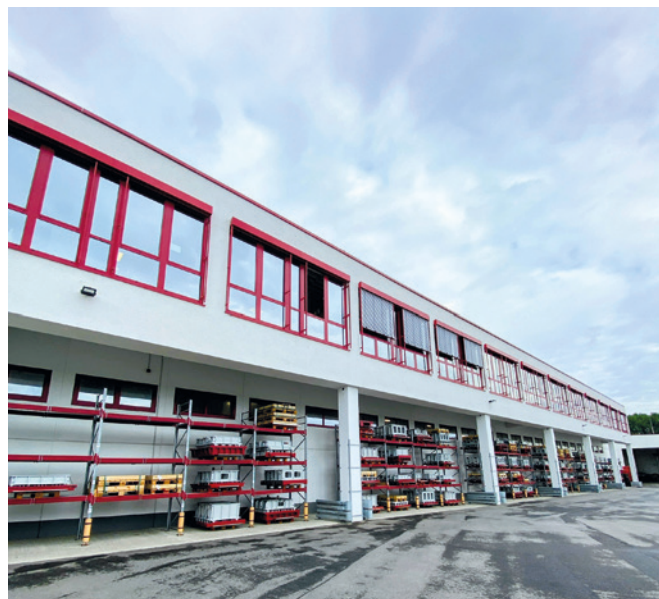
Lo scaffale per la spedizione della Kobra a Lengenfeld
