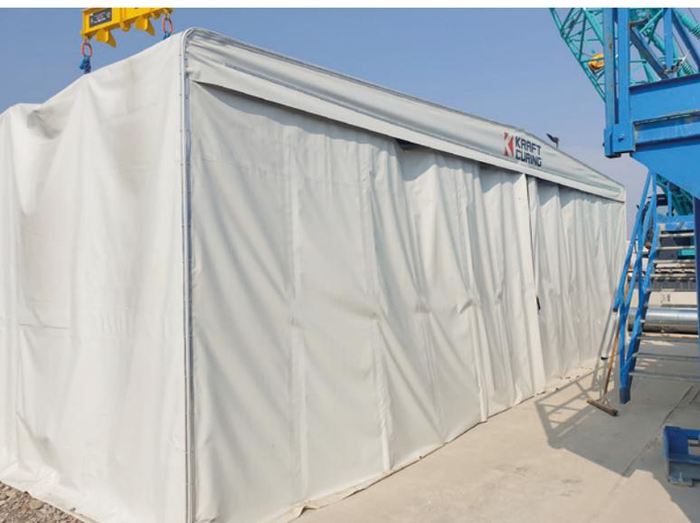
*Uno dei cinque alloggiamenti retrattili (tende) originariamente forniti per l'area di betonaggio temporanea all'aperto. Le tende sono state smontate velocemente e trasportate all'impianto di produzione finale una volta ultimato. Altre 10 tende sono state consegnate come parte della fase 2.*
