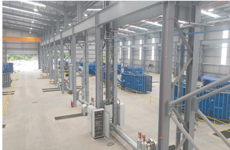
*Le immagini mostrano come la disposizione accuratamente pianificata delle tubazioni del vapore si inserisca nell'area di produzione in modo da non interferire con il processo di betonaggio.*
