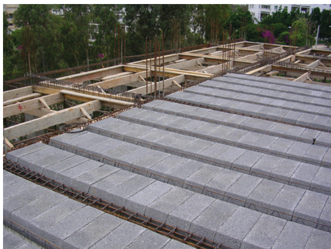
Situation d'installation de hourdis sur le chantier
