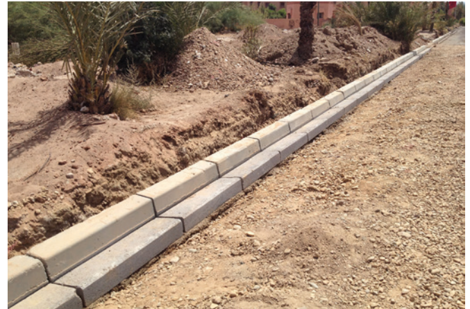
Chantier près de Marrakech
