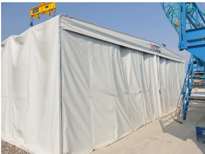
*L'une des cinq enceintes de cure repliables initialement livrées pour la zone de production extérieure. Similaires à des tentes, elles ont pu être rapidement démontées et déplacées vers le hall de production définitif. Dix enceintes supplémentaires ont été livrées à la phase 2 du projet.*
