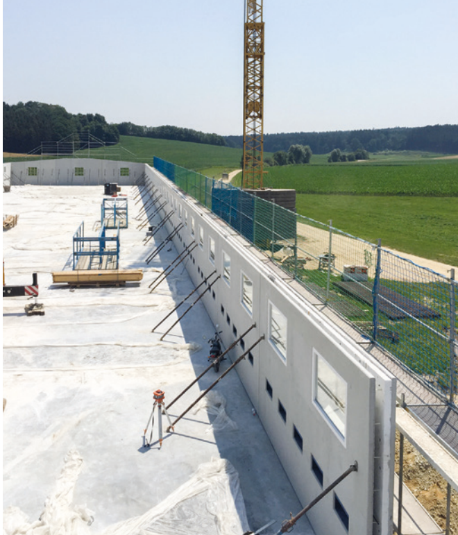
Les murs thermiques sont également utilisés dans la construction agricole, comme ici pour un poulailler.
