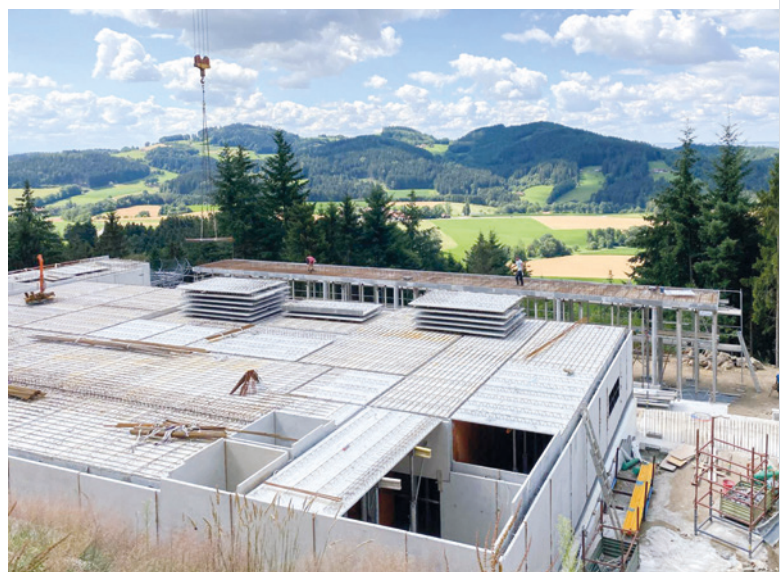
L'auberge de montagne du parc de loisirs d'Edelwies dans la forêt bavaroise est en cours de construction avec les éléments préfabriqués de la nouvelle usine.
