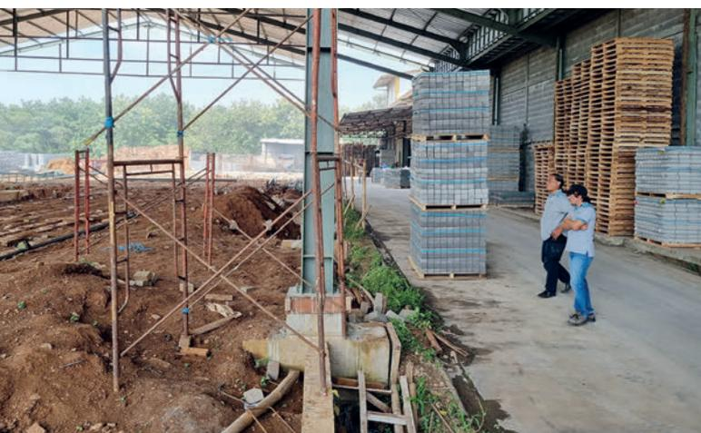
*Fundamentarbeiten für die neue Betonsteinlinie, rechts im Bild die Halle der Betonsteinmaschine Hess RH 1500-3, die 2010 erworben wurde.*
