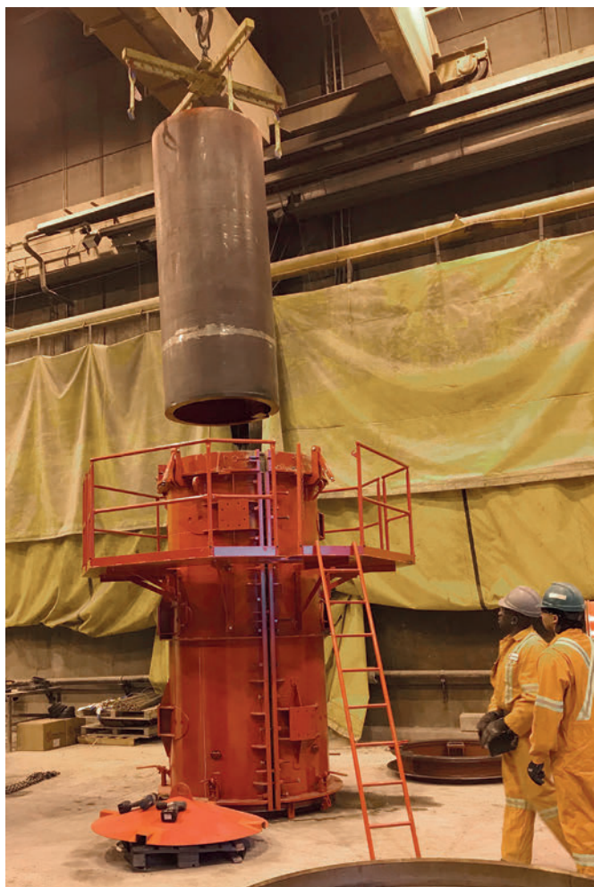
Beginn des Entschalungsprozesses - Entnahme des Formkerns
