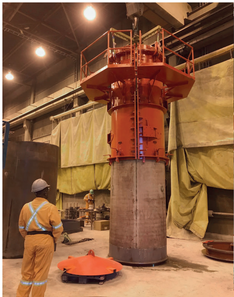
Entschalen des Formmantels - Ausgehärtetes Vortriebsrohr auf Untermuffe
