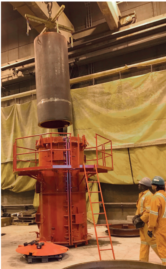
拆模过程开始——拆除模芯
