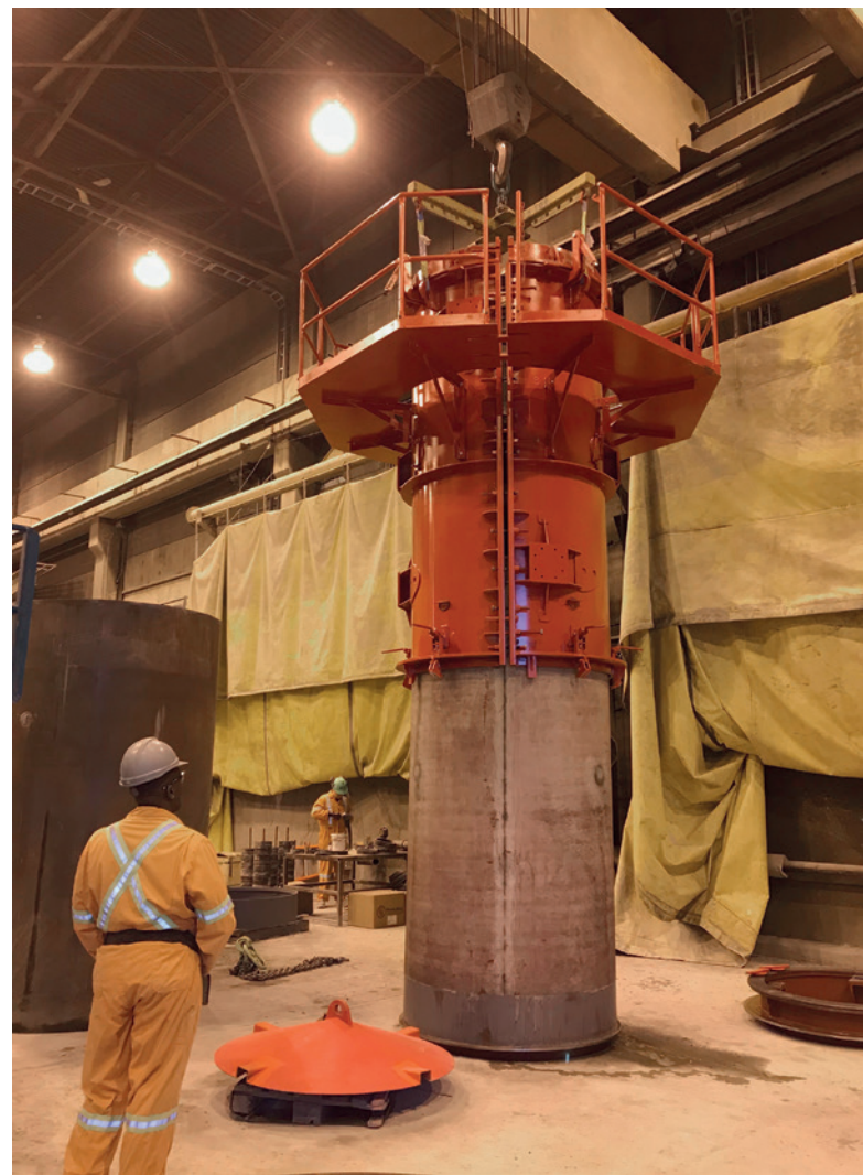
模具护套的拆除 - 基础托盘上已固化的顶管
