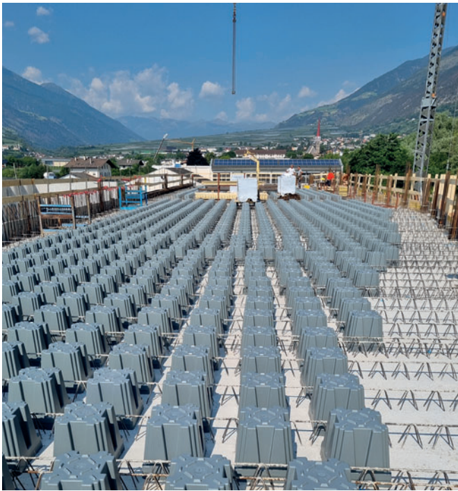
Green Code Eco Slab® комплектуется на месте монтажа верхней частью GC, т.е. верхней половиной проеомообразователя, которая доступна в различных вариантах для перекрытий разной толщины
